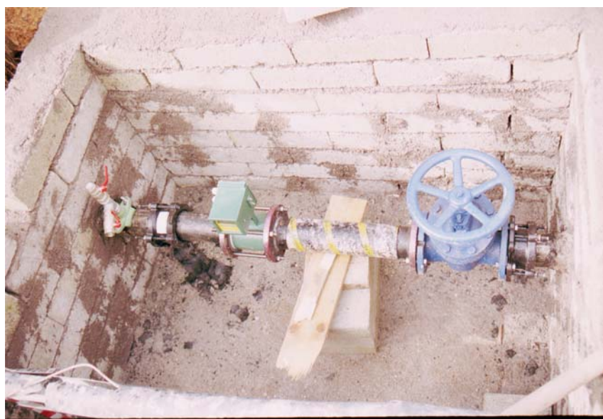
Fig.4 Pozzetto tipo in fase di realizzazione
